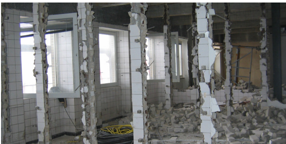
Im 3. Obergeschoss entstehen neue Laborachsen
